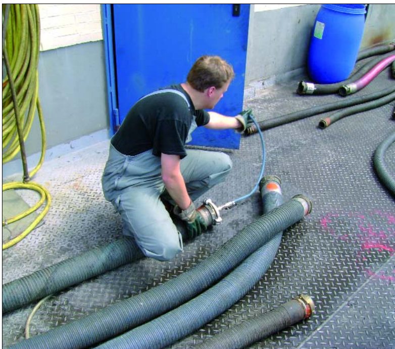
Bild oben: Schlauchleitungen müssen mit dem 1,5-fachen des Betriebsdruckes abgedrückt werden. Hierbei ist Wasser als Druckträger zu verwenden – aus Arbeitsschutzgründen darf keinesfalls mit Pressluft gearbeitet werden!
